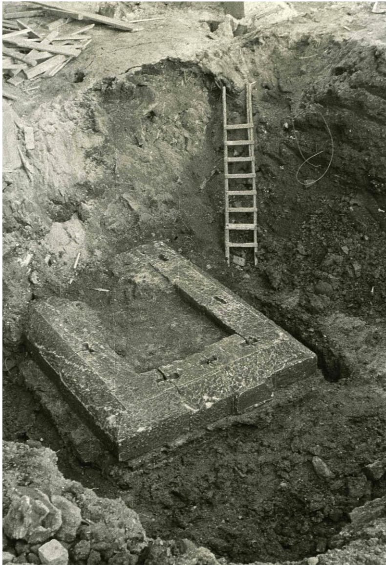
Fundament eines römischen Pfeilergrabmals des frühen 1. Jahrhunderts, Ecke Blaubach / Waidmarkt, in dessen erster Quaderreihe die Schwalbenschwanzverbindungen zu erkennen sind
